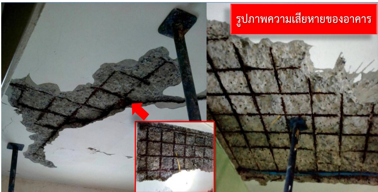
ภาพเหล็กเป็นสนิมเกิน 10 เปอร์เซ็นต์
