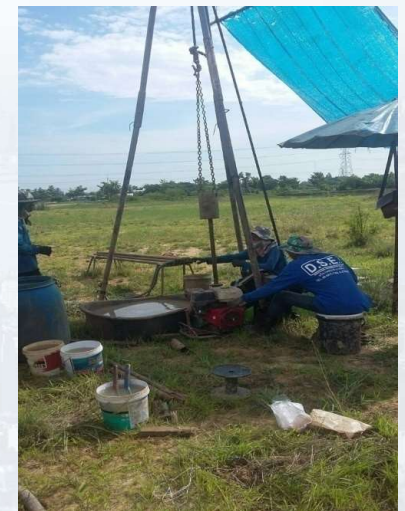
การตอกตึ่มน้ำหนักร เพื่อบีบ SPT
