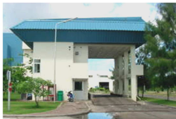
อาคารเครื่องขังมูลฝอย
