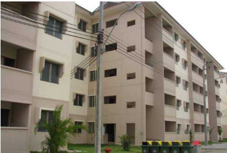
บ้านเอื้ออาทรอาคารชุด สูงไม่เกิน 5 ชั้น
