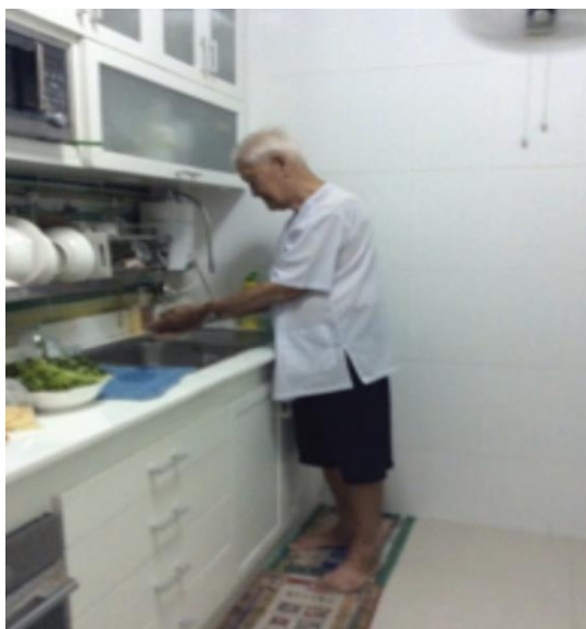
อ่างล้างมือสูงจากพื้น 80 เซนติเมตร
