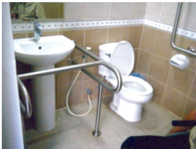
การติดตั้งราวเกาะในห้องน้ำ-ห้องส้วม
